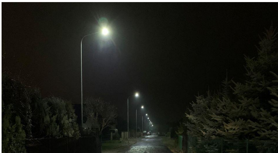
Zdjęcie nr 10 – oświetlenie przy ul. Zygmunta I Starego
